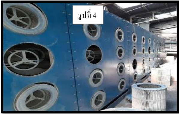
รูปที่ 4 การตรวจเช็คสภาพไส้กรอง
