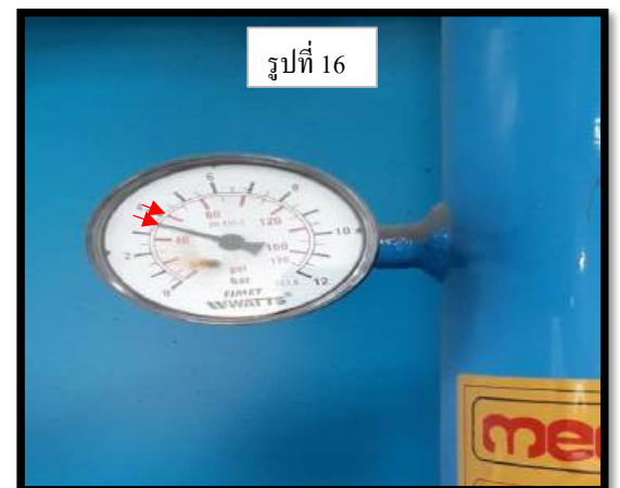
รูปที่ 16 เกจวัดแรงดันลมระบบ Pulse ใส่กรอง
